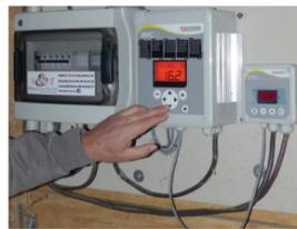
Le système peut être piloté de manière automatique avec une sonde thermique
